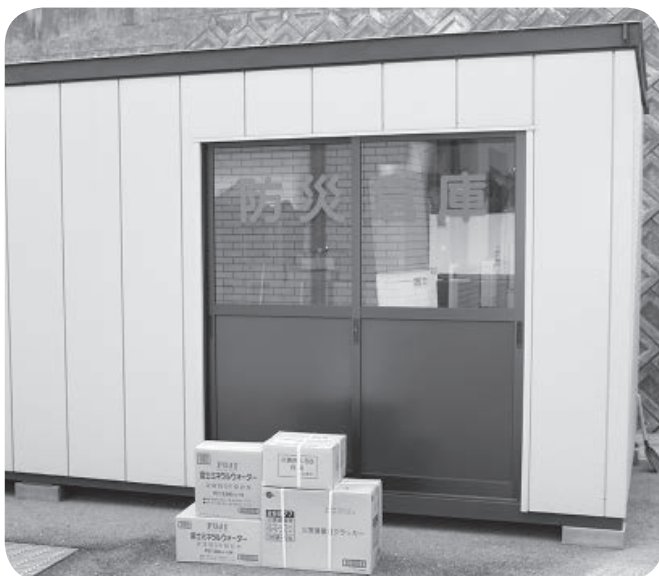
備蓄倉庫と備蓄品
