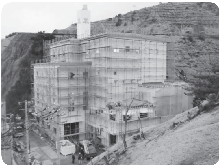
完成間近のごみ焼却施設
