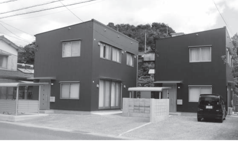
完成した横防家族用住宅
