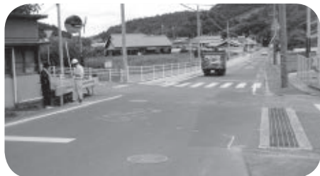
配水管移設場所
