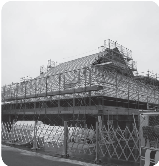
工期に間に合うのか町民会館
