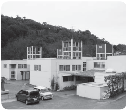
落下防止工事などを行う幼稚園
