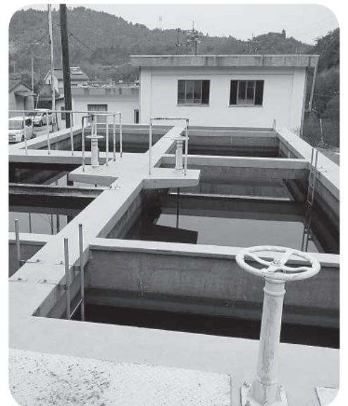
新設予定の浄水場沈澱池
