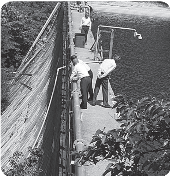
ヘキダム堤防
