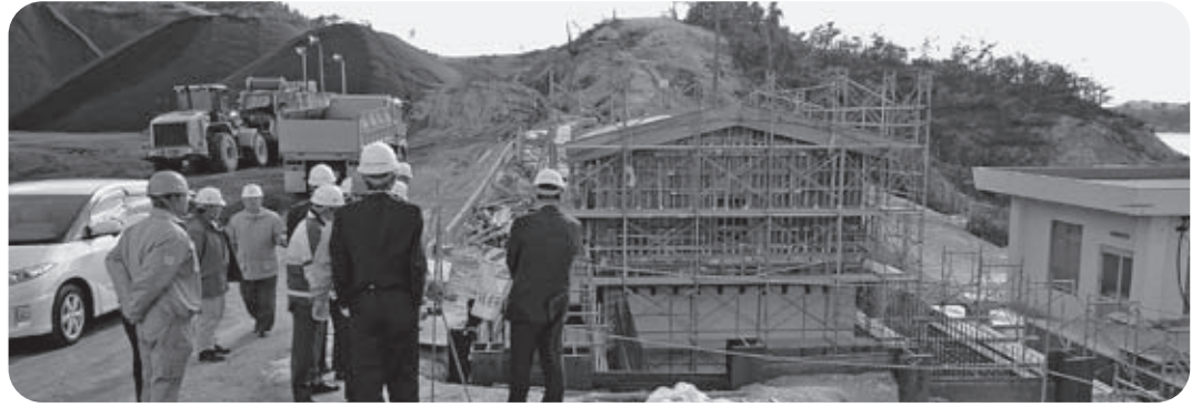
工事中の鶴石受水場ポンプ室を視察
