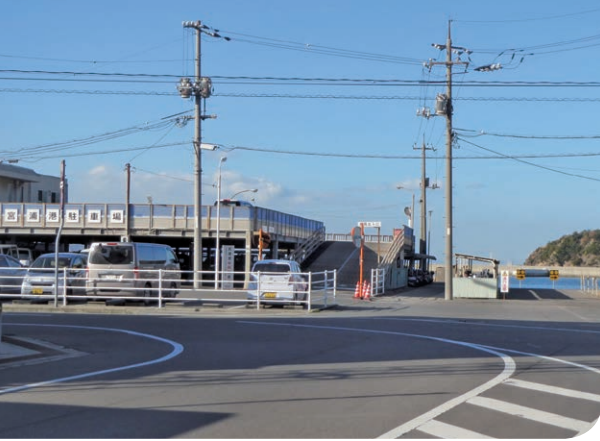
宮ノ浦雨水ポンプ場建設予定地
