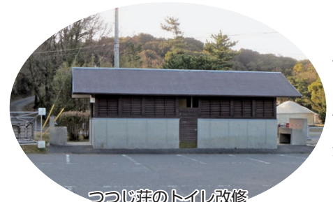
つづじ荘のトイレ改修
