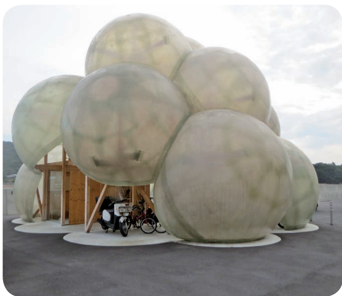
急がれる暑さ対策 (直島港ターミナル)
