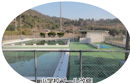
小学校プール改修
