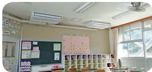
教室にエアコン設置
