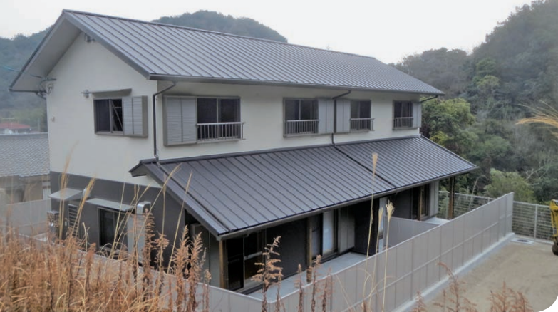
新築された町営京ノ山住宅
