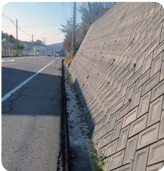
溝蓋の設置は
